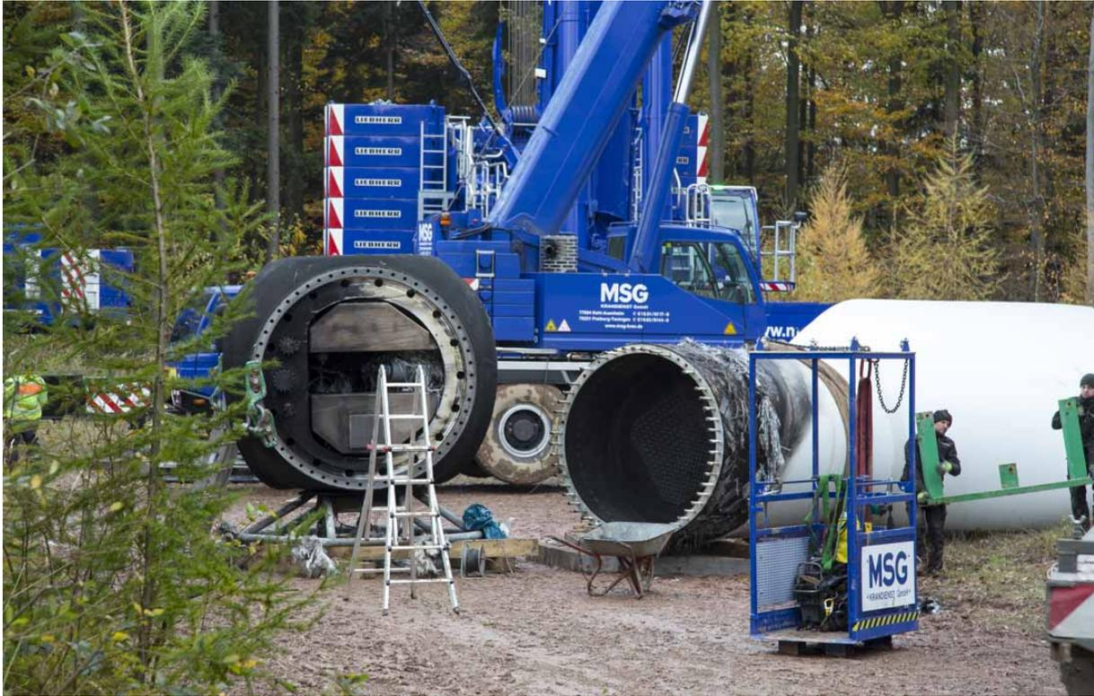
Quelle: Bettina Haßler; Abbau einer zerstörten Windkraftanlage nach Brand in Lahr (2013)
