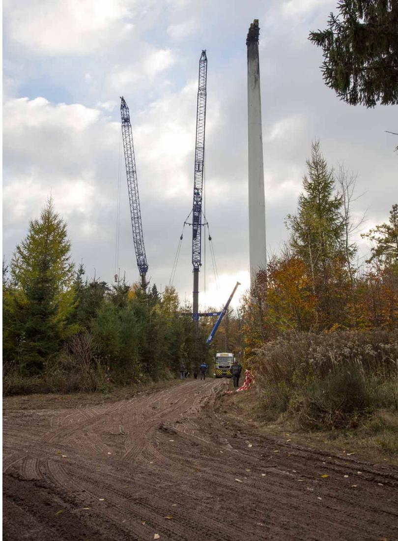
Quelle: Bettina Haßler; Abbau einer zerstörten Windkraftanlage nach Brand in Lahr (2013)
